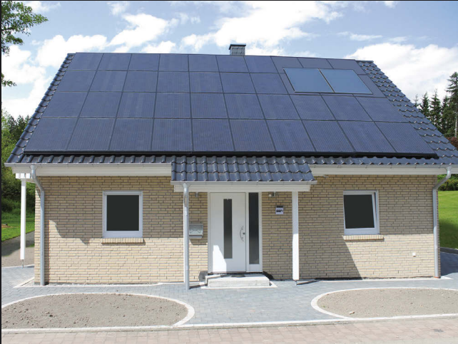
SOL-50 mit Verblendung von zwei Thermiekollektoren
