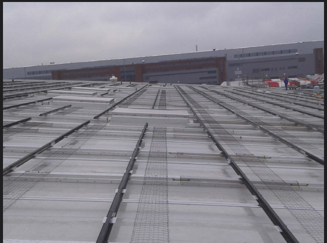
SOL-50 Direktmontage Energie-, Bildungs-, Erlebniszentrum Aurich (EEZ)
