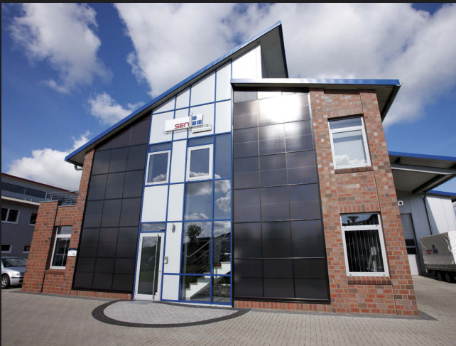
SOL-50 Fassadenanlage mit Verblendern in der Schräge
